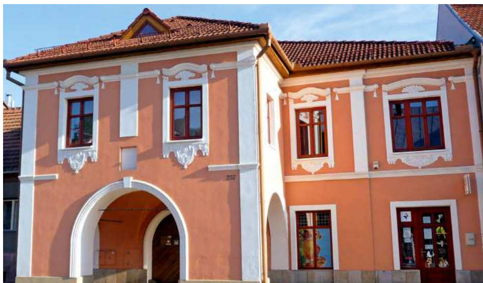
Budova CK INTACT - studium v zahraničí, s.r.o., Hornoměstská 357, Velké Meziříčí
